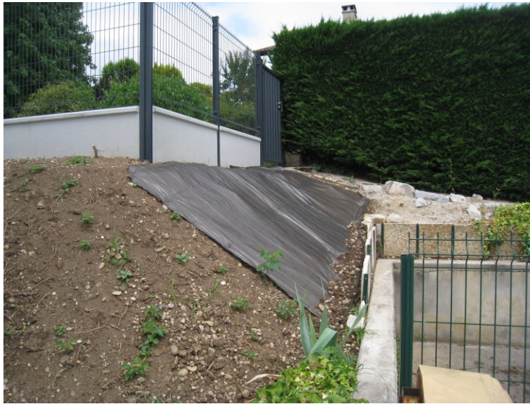
Photo 35 : bâche « Paillex » sur talus.
