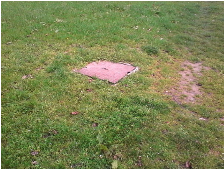
Photo 33 : Trou au ras du sol, la Colombinière.
