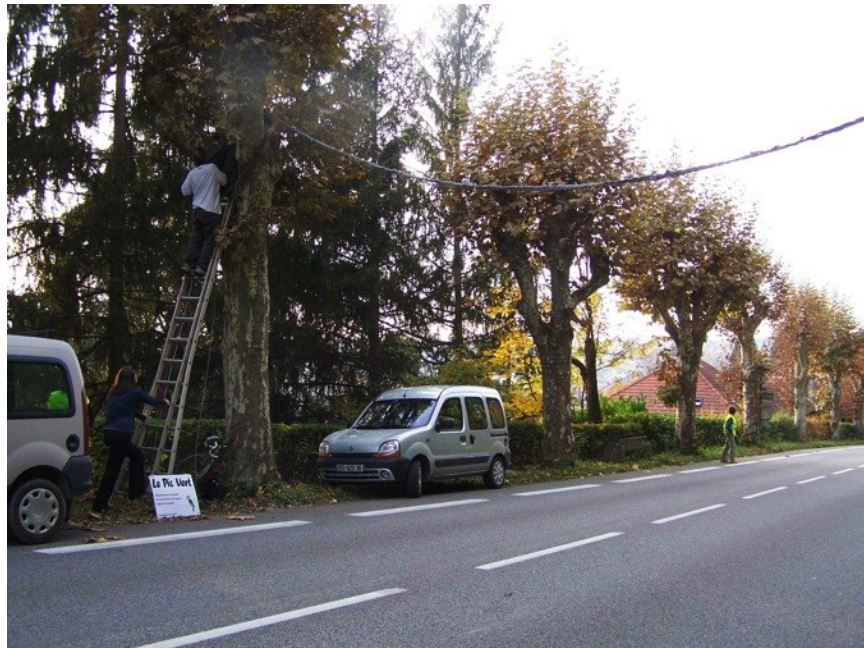
Photo 26 : pose d'une passerelle à écureuil sur la RD520, à Voiron en 2010. M. Botton / Le Pic Vert.
